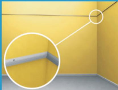
Sobre la traza del nivel, fijar el perfil Perimetral L utilizando clavos de acero o tacos tipo fisher de 6mm o más.
