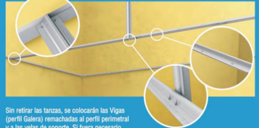
Sin retirar las tanzas, se colocarán las Vigas (perfil Galera) remachadas al perfil perimetral y a las velas de soporte. Si fuera necesario unir dos perfiles Galera, se deben solapar 15cm y remachar. Se utilizarán remaches tipo
