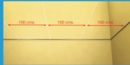
Se colocará una tanza tensada a 100cm de la pared y al nivel del perfil Perimetral. Debe colocarse en el sentido opuesto al sentido de los elementos estructurales del techo (correas, vigas, etc.) Esta tanza servirá como nivel para las velas y las vigas. Repetir esta operación colocando tanzas cada 100cm hasta cubrir toda la superficie del local.
